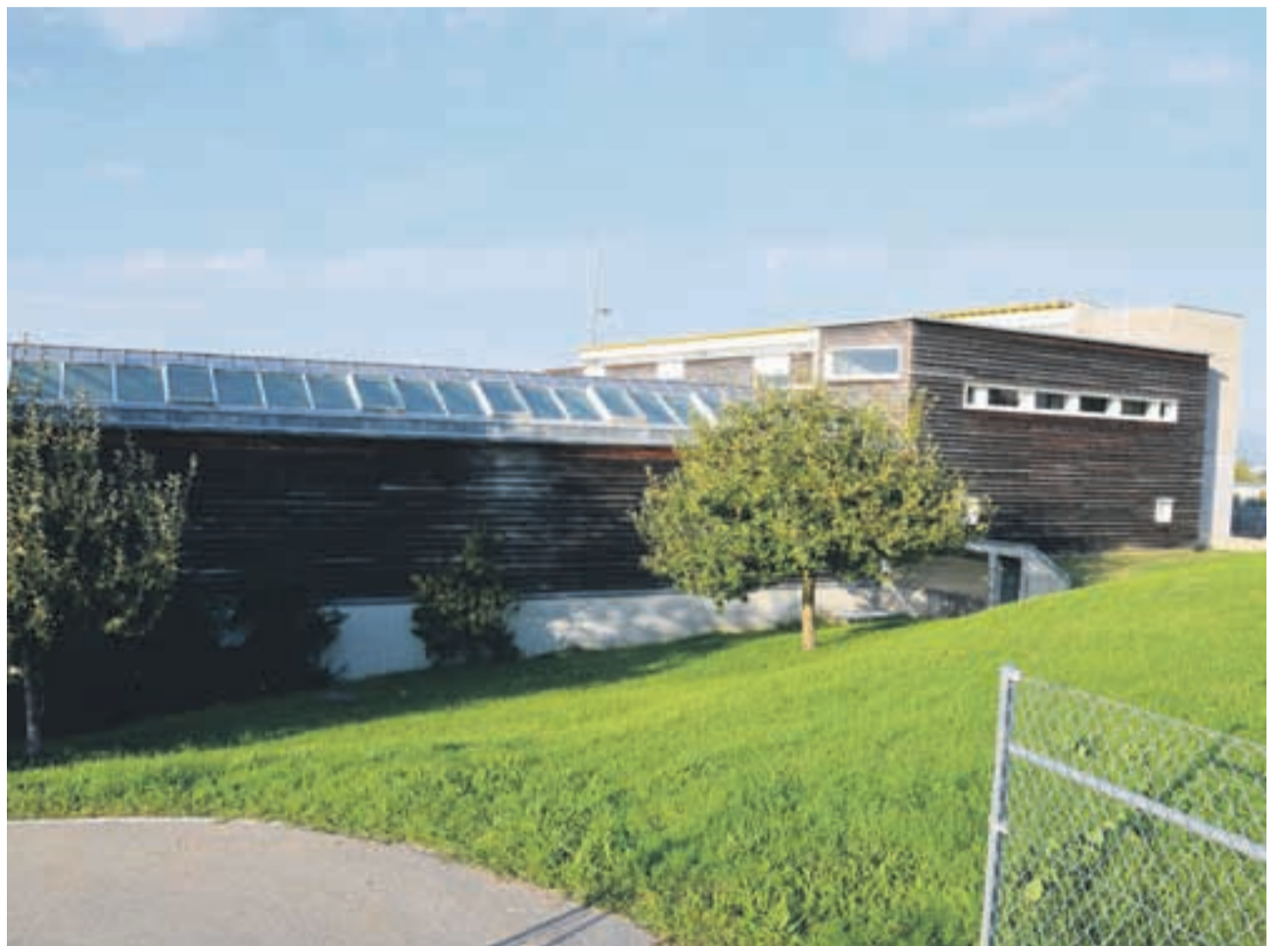
Die Sicherheit der Schüler und Lehrpersonen steht für die Verantwortlichen des Bezirks an oberster Stelle. Deshalb behandelt er die Sanierung des Schulhauses Riedmatt prioritär.
