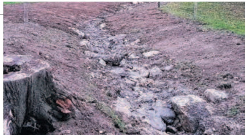
Im renaturierten Bachbett wird das Wasser verlangsamt.
